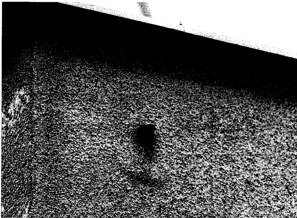
Fot. 2. Otwór po lewej stronie (część A budynku).
